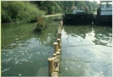
Bau eines neuen Wellenbrechers (Palisade)
